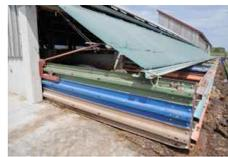
Wolfgang Krämer hat eine besondere Idee in die Tat umgesetzt: Die Ausläufe seines Maststalles können wie Schublade eingezogen werden. Ein 0,4 kW-Motor treibt eine Welle
