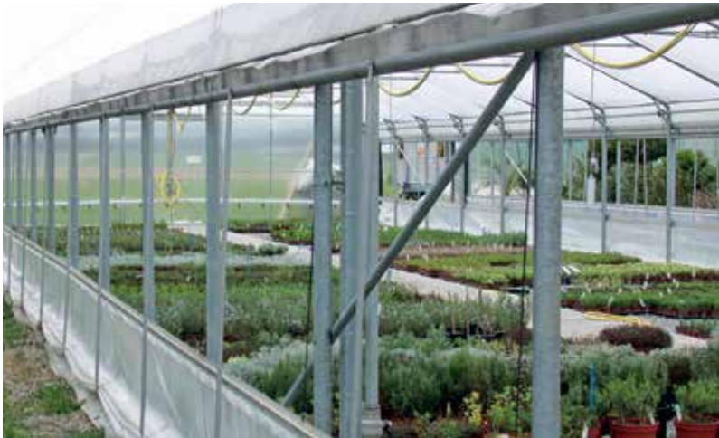
Verstellbare Seitenwände gewährleisten eine gute Durchlüftung des Gewächshauses und reduzieren damit das Risiko einer Infektion durch Krankheiten.
