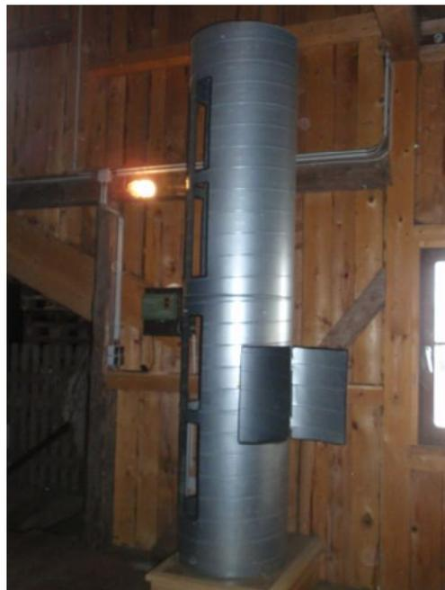
Durch eine hintere Öffnung im Warmluftverteiler können Säcke z. B. zur Trocknung von Kräutern, Brennesseln oder Löwenzahn eingehängt werden.
