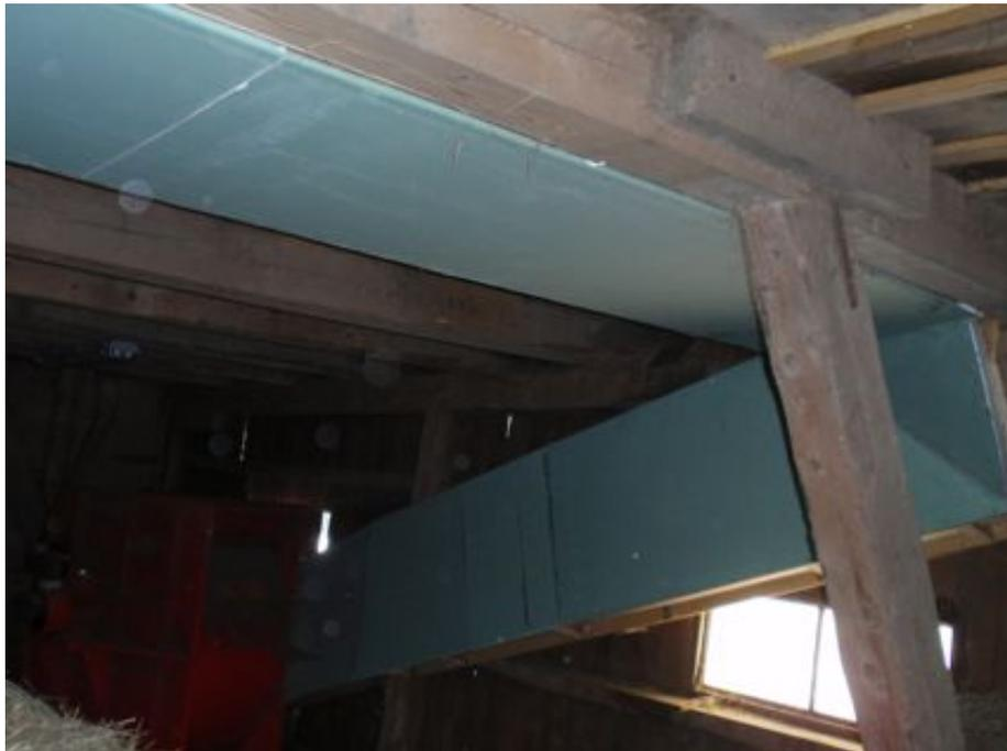
Durch einen Luftkanal wird die Warmluft zum bestehenden Druckgebläse geführt. Der Luftkanal ist mit Spiro-Rohren, größtenteils aber mit feuchtigkeitsbeständigen Gipsplatten ausgeführt. Der Kanal verläuft teilweise unter der Tram-Decke der Tenne, wobei der innere Tramabstand gleichzeitig die Kanalbreite ergibt. Durch einen Schieber kann – je nach Witterung – die Mischung von beheizter Warmluft mit der Außenluft dosiert werden.
