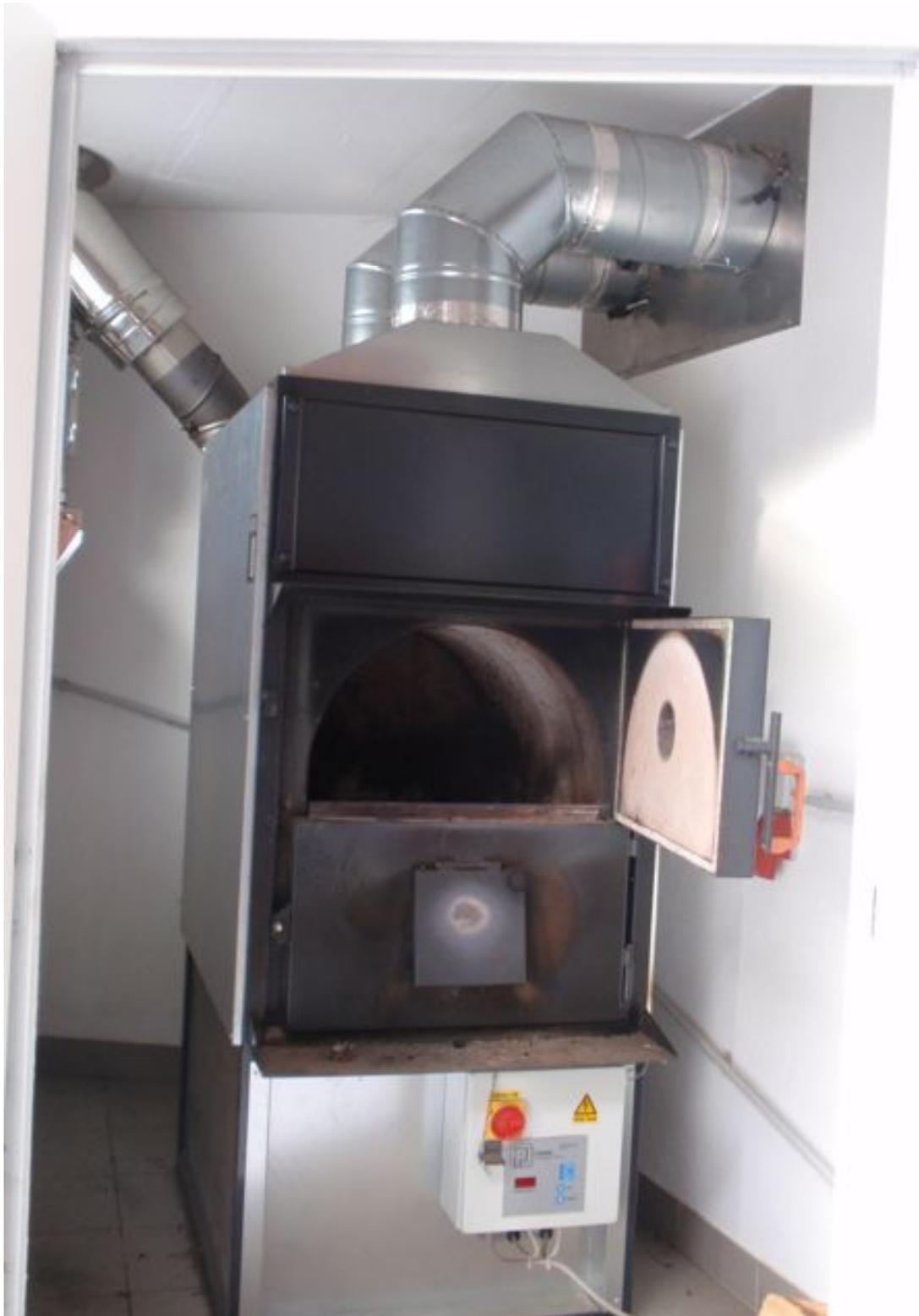
Das Herzstück ist ein Warmluftkessel mit einer Leistung von fast 100 KW.
