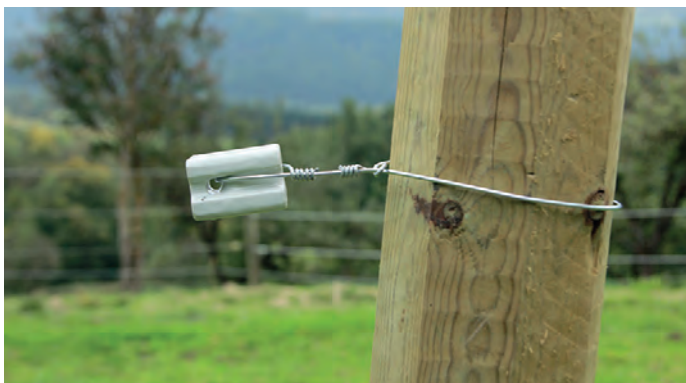
Spezielle Knoten zur Montage der Isolatoren und Federn.
