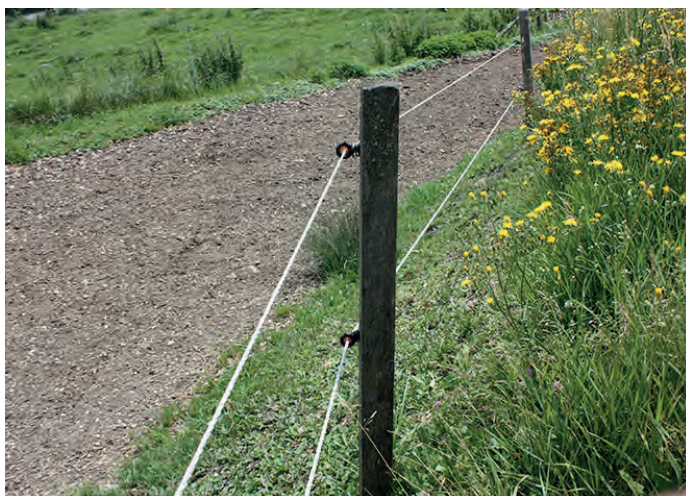
Führungsisolatoren, Litze oder Band halten länger, wenn sie sich frei im Isolator bewegen können, weil der Zaun elastisch bleibt.
