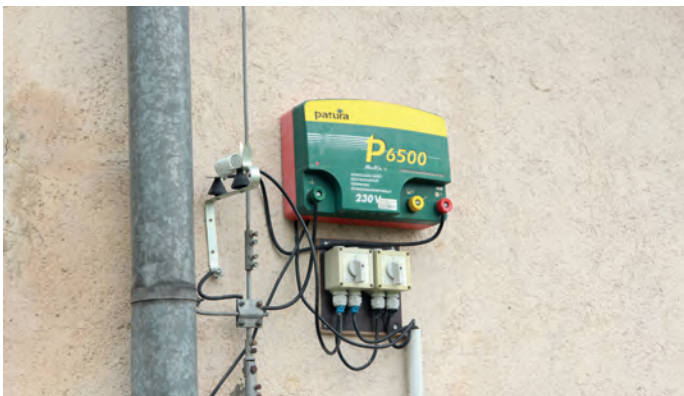
Weidezaungerät mit Hochspannungskabeln und Blitzschutzanlage
