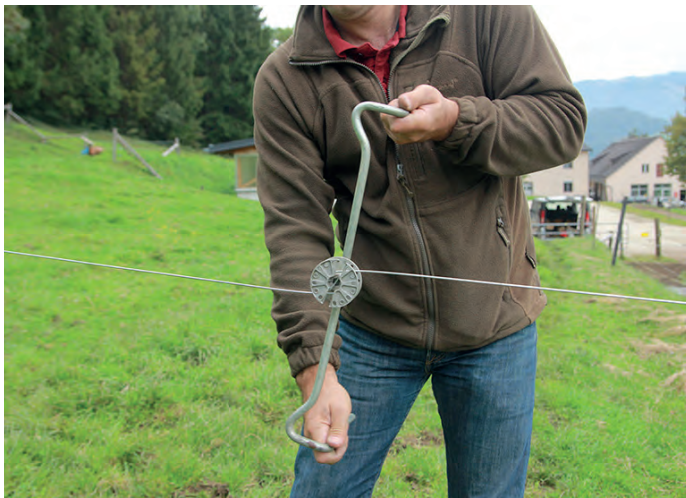
Mit dem Drahtspanner wird der Draht gespannt
