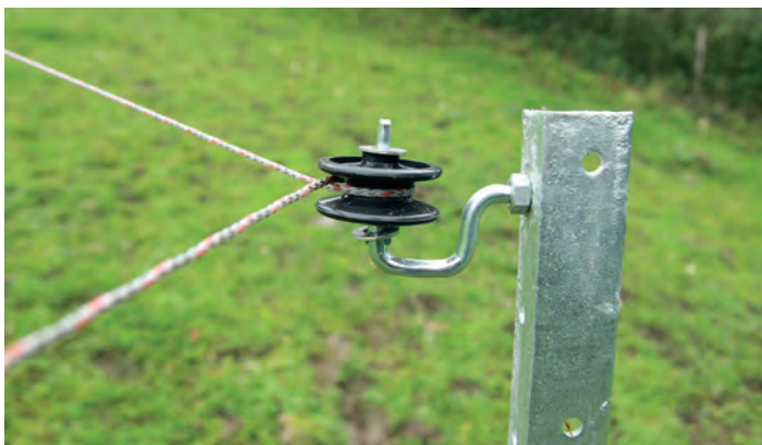
Stabile Ecksteher mit speziellen Isolatoren erhöhen die Festigkeit des Zauns.
