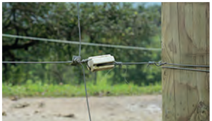
Halteisolatoren müssen Zugkräfte des Zauns aufnehmen können.
